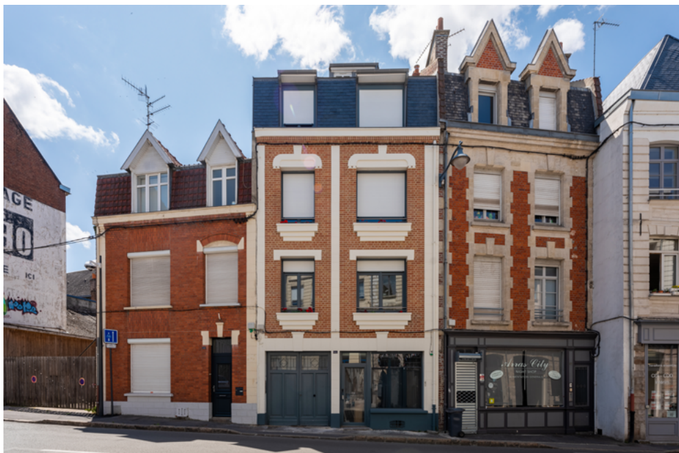
Acquisition #6 - 55. rue des 3 Visages 62000 Arras
