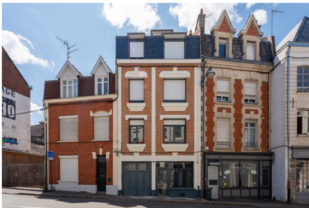
Acquisition #6 - 55, rue des 3 Visages 62000 Arras
