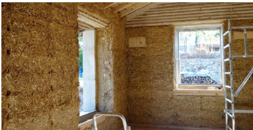
Kyaneos a isolé les murs périphériques de cette ancienne grange en botes de paille, un isolant naturel, dont le niveau d'énergie grise nécessaire à sa production est très faible. En plus d'être entièrement biodégradable, il a une durée de vie de 100 ans.
