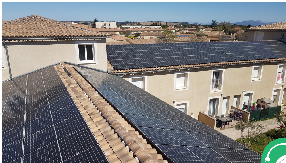
Installation en cours à Sorgues (84700)
